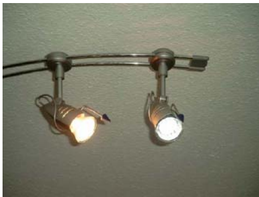
รูปที่ 2 ด้านขวาเป็น LED ที่ให้แสงสว่างเท่ากับหลอดฮาโลเจน ที่ใช้กำลังเพียง 1.25 W จากเดิมที่หลอดฮาโลเจนใช้ 20 W
